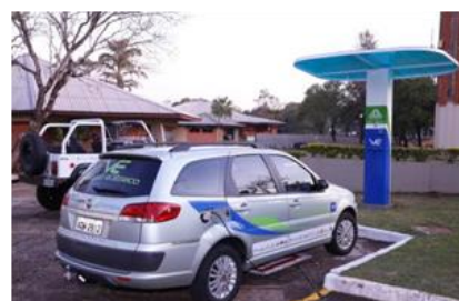
Vehículo Eléctrico siendo abastecido en el electropuesto de la Villa B.
