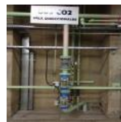
Tanque de CO 2 y Válvulas Direccionales - Sistema Nuevo
