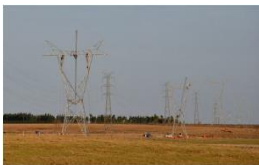
Montaje de las Torres
