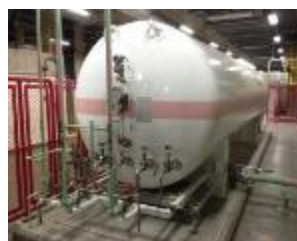
Tanque de CO 2 y Válvulas Direccionales - Sistema Nuevo
