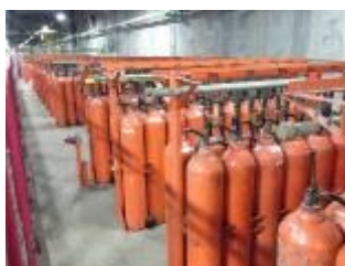
Conjunto de Baterías Principales y Reservas CO 2 y Válvulas Descarga Rápida y Lenta - Sistema Antiguo
