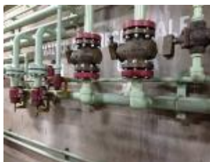
Conjunto de Baterías Principales y Reservas CO 2 y Válvulas Descarga Rápida y Lenta - Sistema Antiguo
