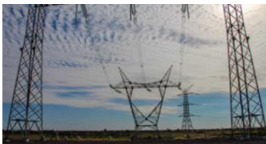
Pórtico de Salida de la Línea en la Subestación de la Margen Derecha, ITAIPU
